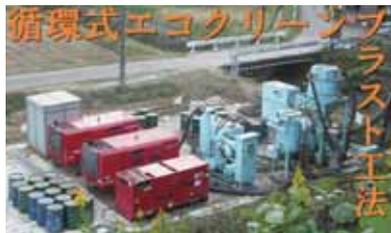
Rc- I 塗装系等で現場ブラストを行う際に、従来は塗膜片・ケレンダストだけでなく使用した研削材も全て産業廃棄物として処理されていました。循環式エコクリーンブラスト工法では研削材を回収・再利用することにより、塗膜片・ケレンダストのみを産業廃棄物として処理するため、産業廃棄物の発生量を97%以上削減できます。展示ブース内ではブラストシステムや施工中の様子などを模型や動画を用いて紹介します。
