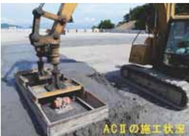
アッシュクリートTypeⅡは石炭灰原粉を大量に使用し、セメント、石膏と水を混合した材料を現位置で締固める人工地盤材料です。比重が約1.7、一軸圧縮強度5N/mm<sup>2</sup>以上の固化体であるため、液状化、地盤沈下、地すべりなどの心配のない強固で安定した盛土となり、また耐久性に優れ、特別な維持管理を必要としません。また重金属の溶出に対しても、土壤環境基準値をクリアしています。よって、地震によって沈下した地域、および今後の津波対策として地盤の嵩上げにも適した材料です。
