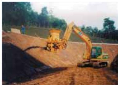
伐採木を破碎した生のチップ材と現地発生土（表土）を緑化基材として利用するリサイクル緑化工法です。森林表土が含まれる発生土を生育基盤材料として利用することにより、自生種による緑化復元が可能です。また、伐採木などをリサイクルすることにより、廃棄物の発生量を抑制しゼロエミッションに貢献します。
