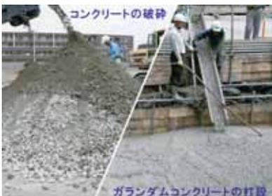
ガランダム工法は、コンクリート構造物の解体材や、震災で生じたコンクリート瓦礫を再利用して、低強度の埋戻し・中詰め・嵩上げ材としての利用から、中・高強度の基礎地盤や基礎構造物を造成、築造することができる技術です。コンクリート瓦礫を破碎してセメントベントナイトスラリーと混合し、ガランダムコンクリートとして打設します。硬化後には配合に応じて5～20N/mm<sup>2</sup>の強度が得られます。コンクリート瓦礫を迅速に再利用するために最大粒径300mmのがれきの利用も可能となりました。コンクリート瓦礫に含まれる微量の重金属類が溶出することもなく安全に利用することができます。
