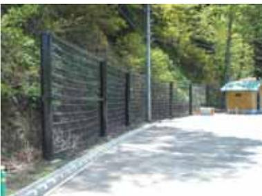
**新開発「蓮根型中空構造（LST）鋼管」を採用した高性能で経済的な土砂災害・防雪・落石対応鉛直柵です。**
