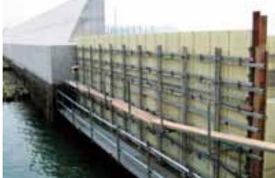
建設工事に係わる資材の再資源化をテーマとして、合板代替型枠として開発された「樹脂型枠カタパネル」は、リサイクル可能・転用性が高い事・産業廃棄物削減・軽量・腐食しない・錆びない・透光性などから多くの現場に導入され始めています。「鉄筋コンクリート造建築物の環境配慮施工指針（案）・同解説」の型枠および型枠工事の項でも、樹脂型枠は、省資源・環境負荷物質低減型として大いに期待できるとされています。
