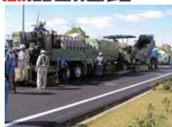
リペーブ排水性舗装の施工状況
